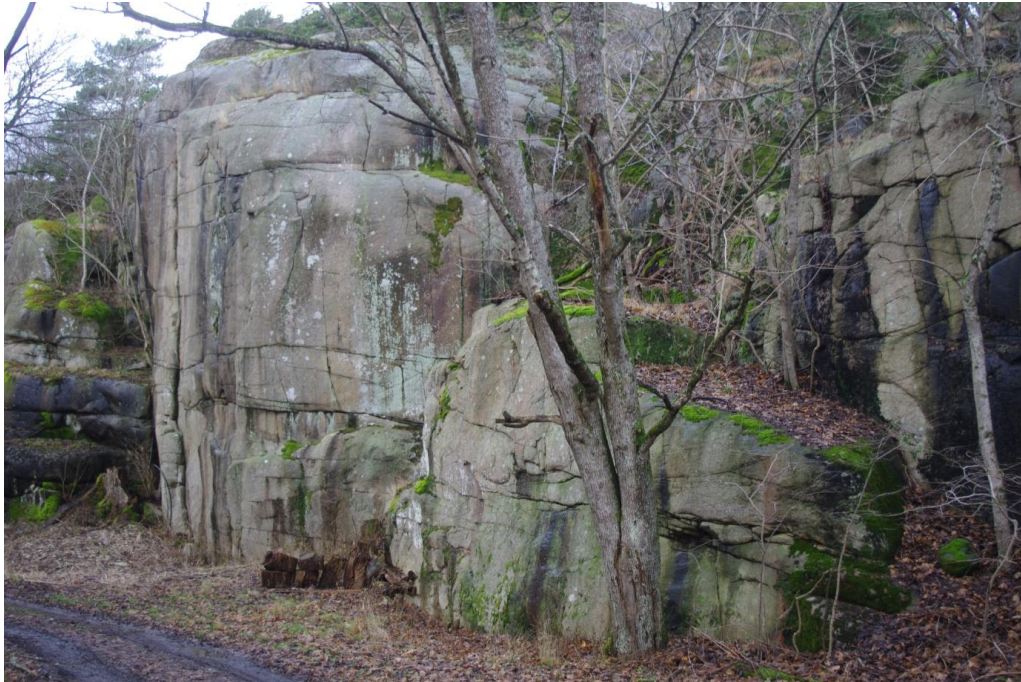
Figur 1 Brant stupande bergslänt vid entrén. Bild tagen mot norr. På fotot syns hur bankningsplanen stupar flackt in i berget åt höger på bilden och att avståndet mellan planen varierar.
