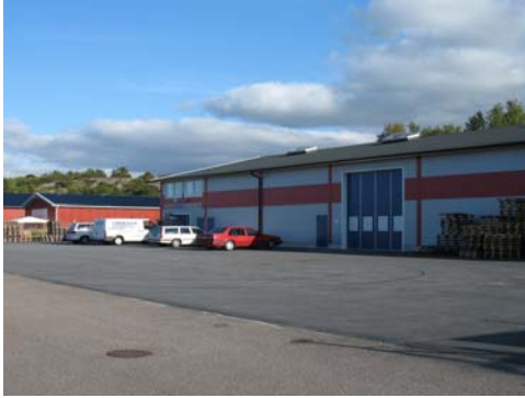
Exempel på verksamhetsbyggnad
