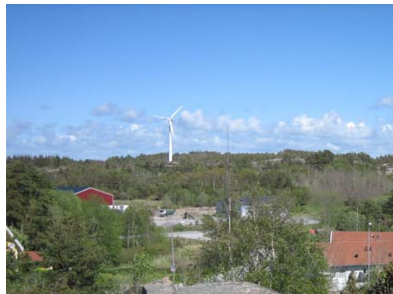
Vindkraftverket i Hamburgsund, sett söder ifrån
