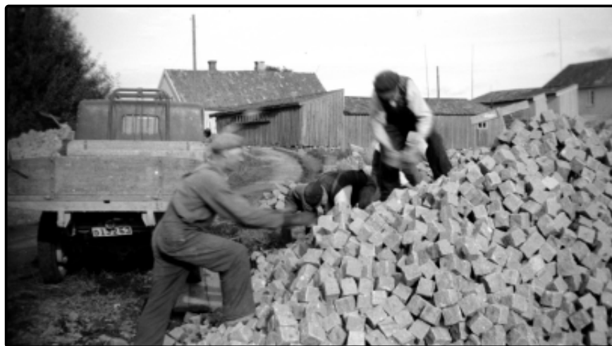
Lastning av knött , alltså gatsten, från de stora stenvallarna till lastbil för vidare transport till fraktfartygen.
