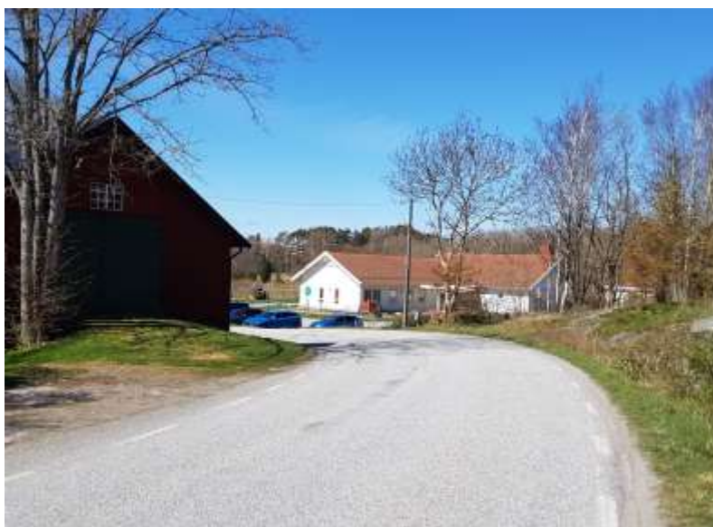
Bild på befintliga Grönemadsvägen. Vägen är smal och det saknas yta för gående. I svängen mot förskolan är det smalt och dålig sikt.
