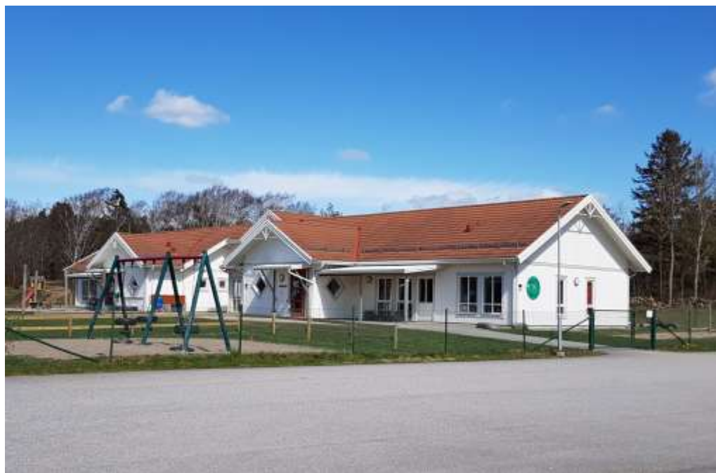
Bild på befintlig byggnad för Ängens förskola.
