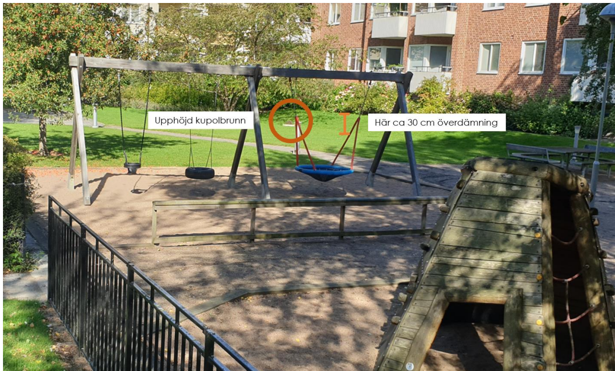
Figur 22 Exempel på överdämningsyta / torrdamm (Augustenborg). En lägre del med upphöjd kupolbrunn där vatten ansamlas först. Vid riktigt stora regn kan även gångbana och lekpark svämma över
