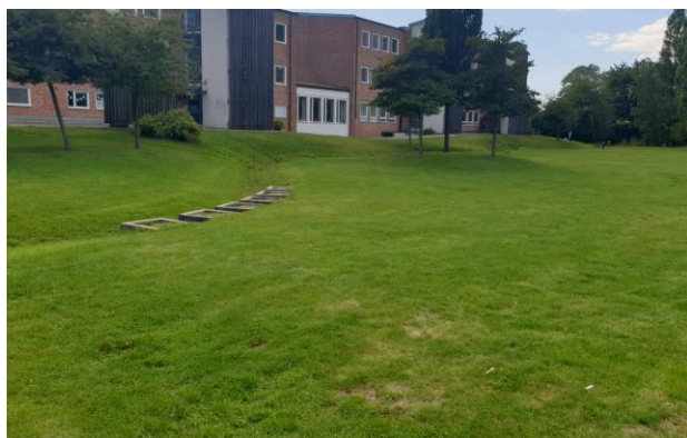
Figur 24 Överdämningsyta (gräsmattan) som svämmar över vid stora regn med en lägre del (svackdike) som svämmar över vid mindre regnmängder
