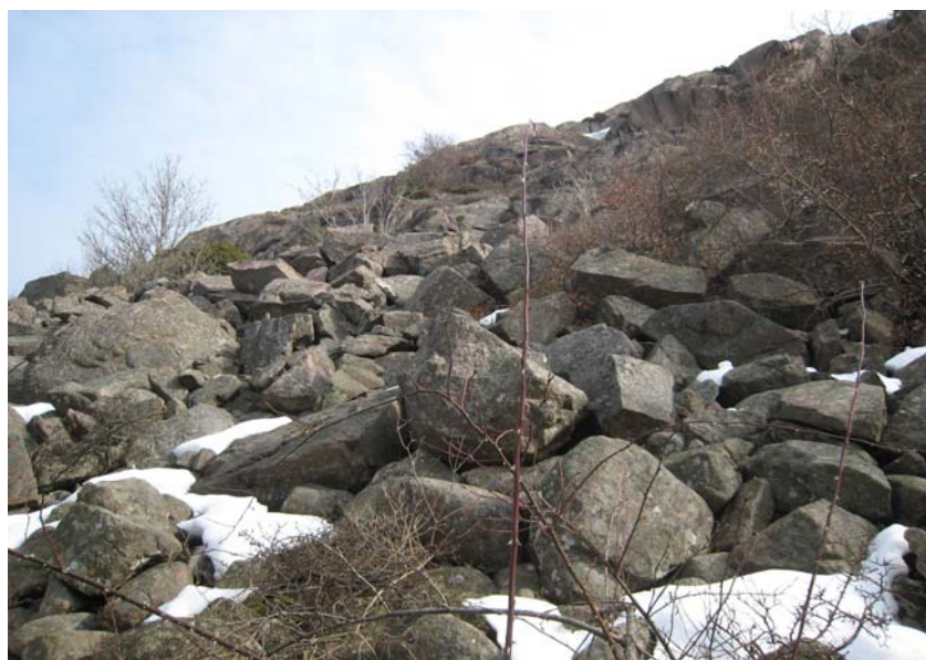
Bild 2. Rikligt med bergblock vid bergspartiet längs Plureviksvägens östra kant.
