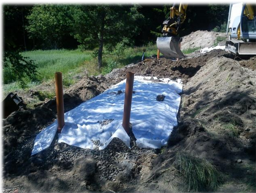
Markbaserad reningsanläggning innan sluttäckning
