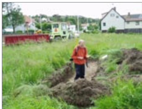
Figur 6. Mattias Öbrink mäter in schakt med GPS. Foto från norr: Per Falkenström.
