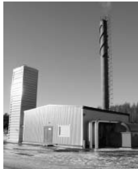
Fjärrvärmecentralen på industriområdet i Tanumsheda.
